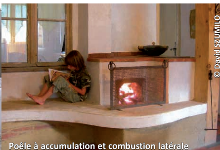
Poêle à accumulation et combustion latérale
